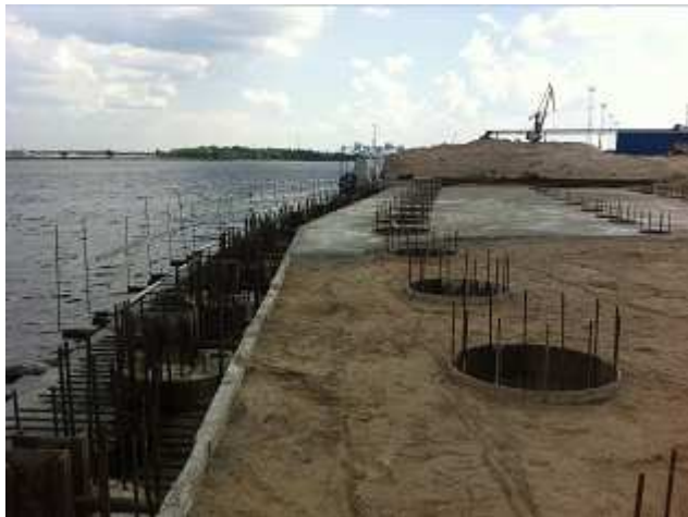
Amarre en construcción
