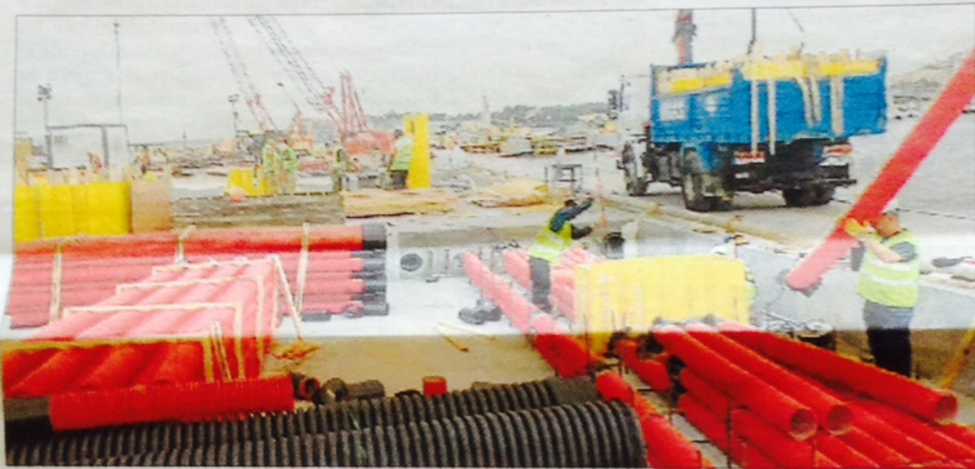
La ampliación del muelle de Ponent ya dispone de tuberías para pasar el cableado eléctrico en el futuro. APB
